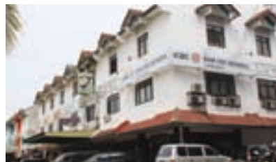
Bekasi Sub Branch Komplek Ruko Mitra Bekasi Jl. Ir. H. Juanda Blok C No. 7 Bekasi 17111 T. (+62 21) 8816 482 F. (+62 21) 8809 316
